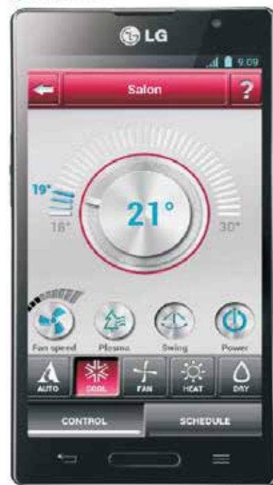
nastavení klimatizačních jednotek
